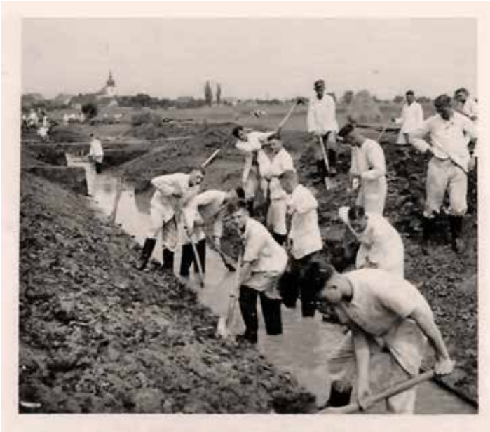
Die historische Aufnahme zeigt den Reichsarbeitsdienst beim Ausheben des Aisch-Flutkanals. Bild: Privatsammlung
